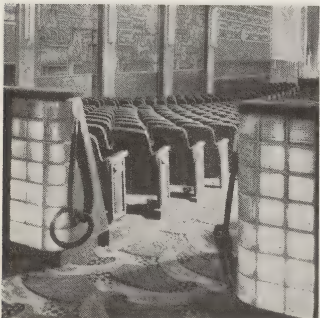
Bloques de vidrio en el auditorio de un teatro moderno, a modo de tabique.
